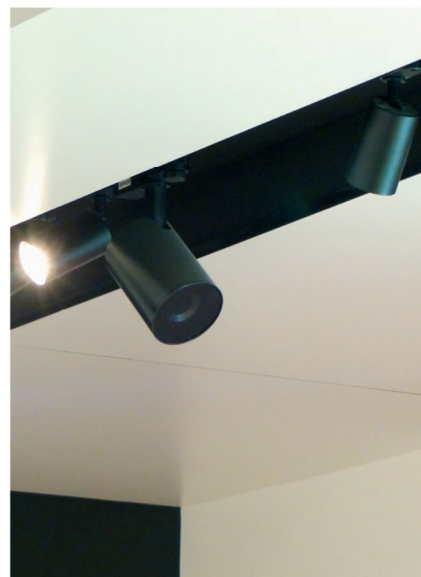
Les transducteurs TRAIL103 ressemblent à s'y méprendre aux spots lumineux.
