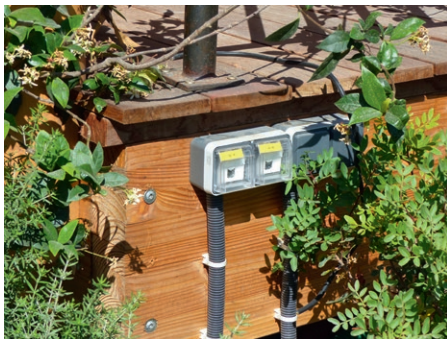
Un réseau Dante est déployé sur le site pour assurer une modularité totale de la distribution audio.
