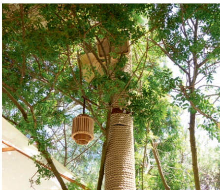
La teinte des enceintes a été choisie pour que ces dernières se fondent dans l'environnement. Il n'était pas permis de percer les arbres. Tout l'équipement a donc été saigné.
